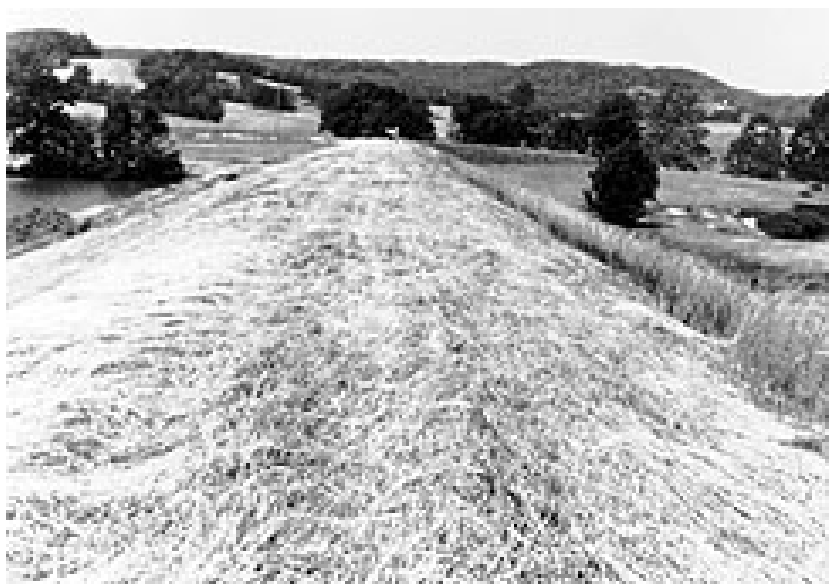
عکس شماره ۱۰ - اسفاده از ریپ ریپ در حفاظت بالادست سد بخصوص در سدهای با مخازن وسیع در معرض باد
