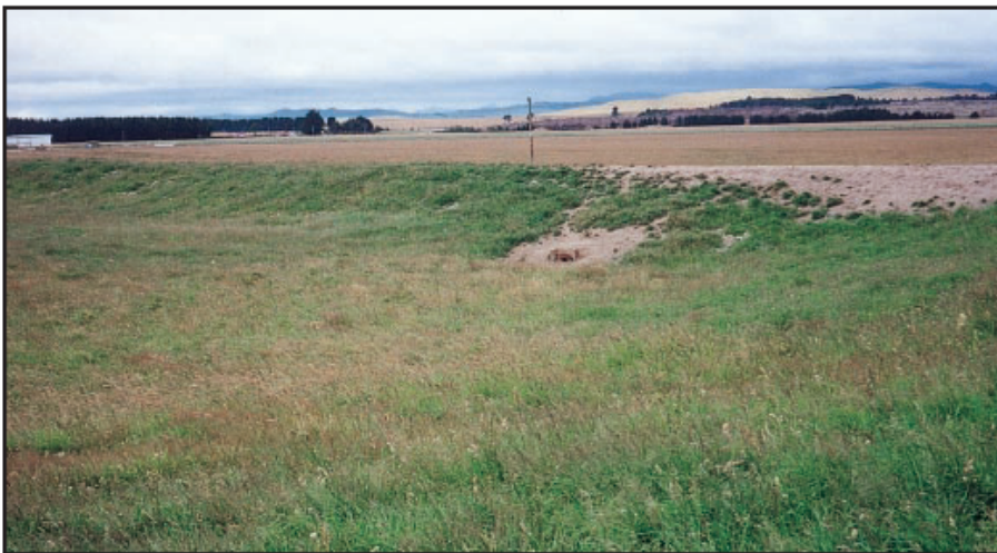
عکس شماره ۶- نمایی از یک سد کوچک آبخیزداری (سد کنترل سیل)
