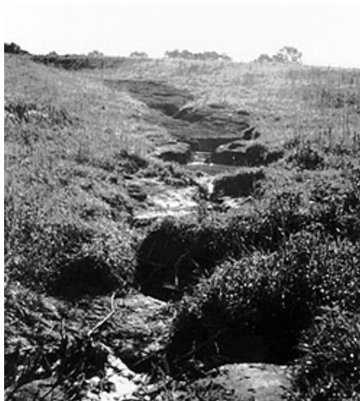
عکس شماره ۱۶- لگد کوبی سرریزهای محافظت شده بوسیله پوشش گیاهی ، عامل شکست سد
