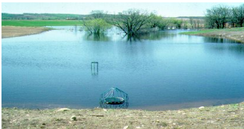
عکس شماره ۵ - یک بند چند منظوره با شیر کنترل و آشغالگیر (سایت هیدرولوژی)
