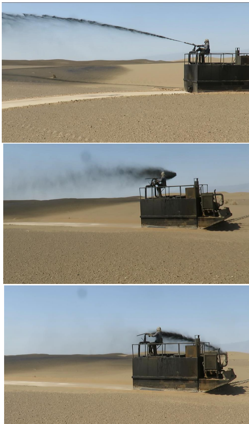
شکل ۲-۲- تغییرات زاویه افقی پاشش مالچ می تواند به بیشتر از ۱۲۰ درجه و به صورت عمودی از ۴۵ درجه تا ۷۰ درجه متفاوت باشد.
