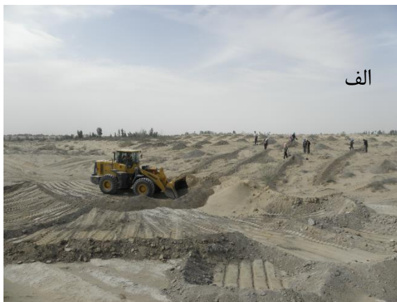
شکل ۱-۵۴- استفاده از ادوات مختلف جهت احداث پشته‌های رسی (الف) ماشین‌آلات و (ب) نیروی کارگری
