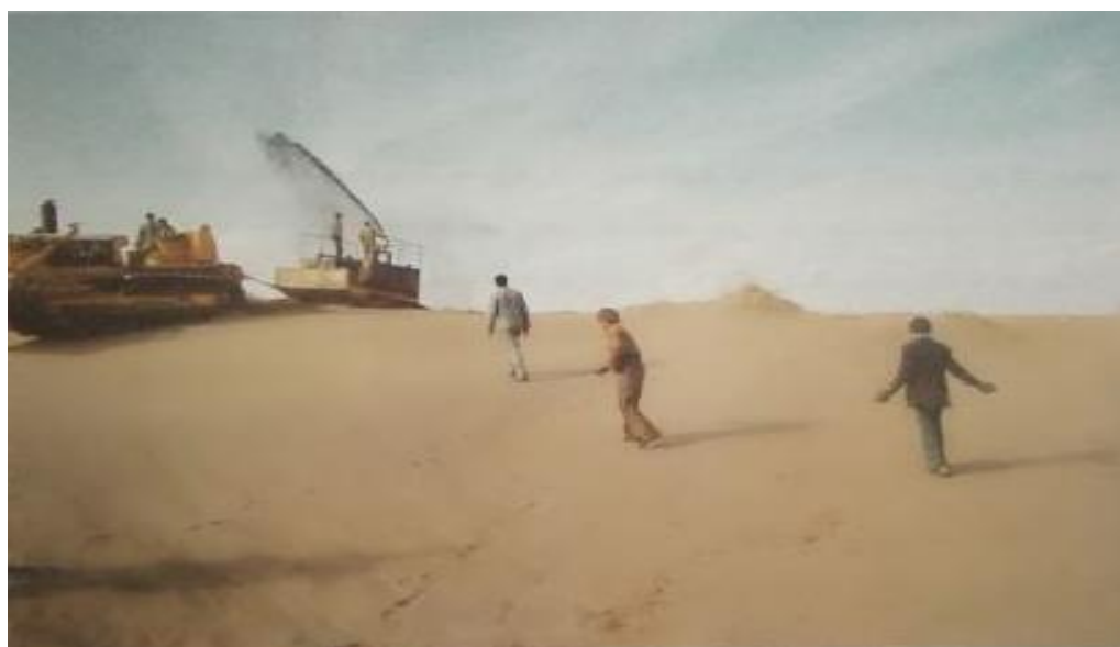
شکل ۲-۴۰- شیوه بذرپاشی روی عرصه مالچ پاشی شده
