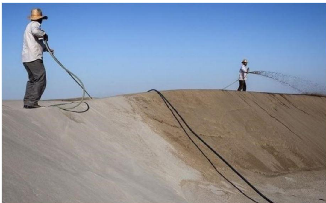
شکل ۲-۴۶- پاشش مالچ رسی بر روی تپه های ماسه ای (نمونه های خاک رس با مقدار معین آب مخلوط و در روی ماسه های روان مناطق بیابانی پاشیده می شود)
