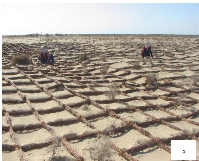
شکل ۱-۲۹- مواد مختلفی جهت ایجاد بادشکن مکانیکی (الف) شیمیایی، (ب) پلاستیکی، (ج) پشته رسی، (د) بقایای گیاهی، (ه) فنس فلزی و پارچه‌ای، (ز) پیکه چوبی و (ر) گیاه مصنوعی (زارع، ۱۳۹۹)
