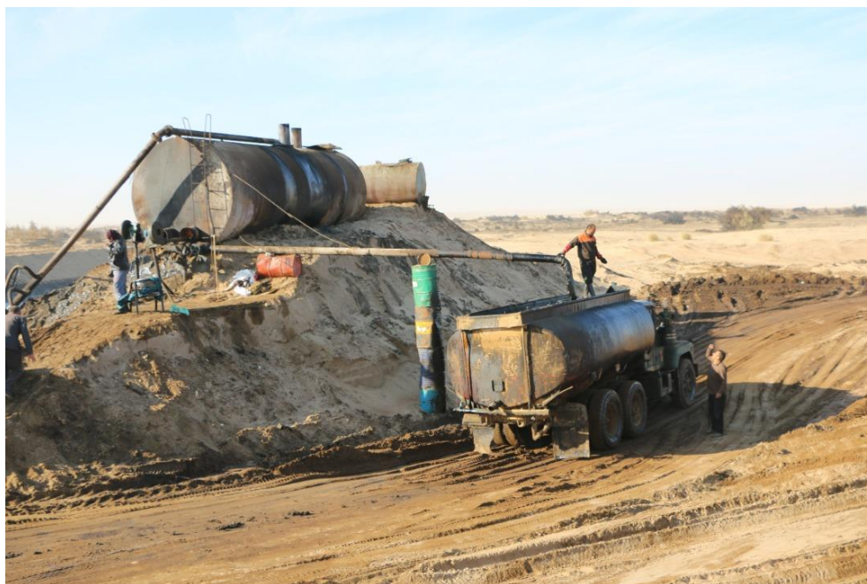
شکل ۲-۱۳- نمایی از کمپ تخلیه مالچ در عرصه (انتقال مالچ گرم شده به داخل کامیون جهت انتقال به داخل عرصه)
