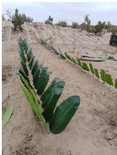
شکل ۱-۲۸- نمایی از بادشکن‌های مصنوعی حاصل از ترکیب بقایای گیاهی و انواع پلیمرها
