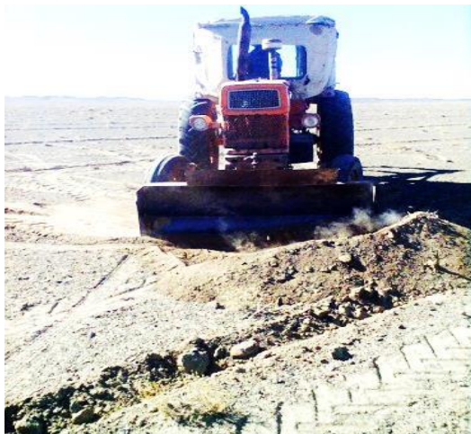
شکل ۲-۷- مراحل احداث هلالی آبگیر با تراکتور
