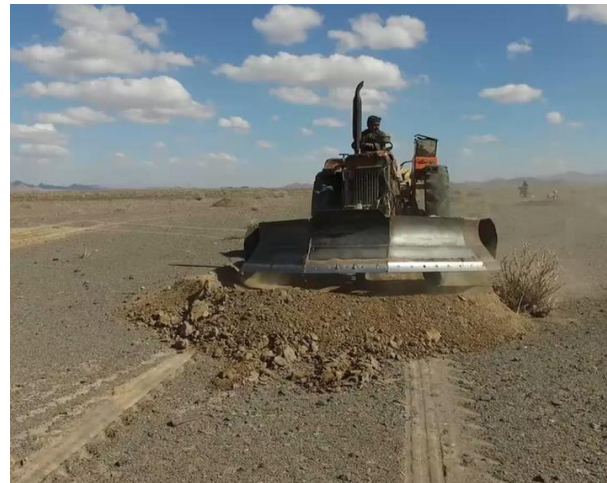
شکل ۲-۷- مراحل احداث هلالی آبگیر با تراکتور
