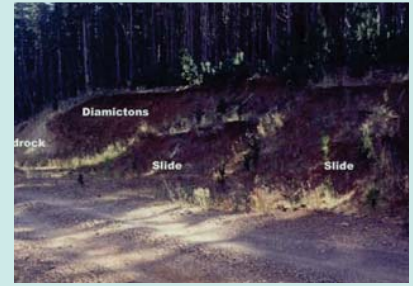
شکل ۲- لغزش دیواره خاکبرداری جاده (ارسکین، ۲۰۰۵)
