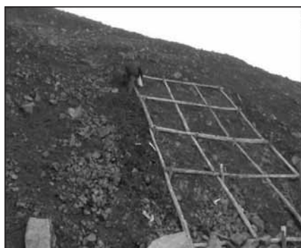
نصب شبکه روی دیواره
