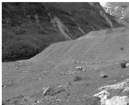
نمایی از عملیات اجرایی انجام شده
