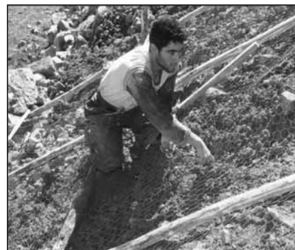
نصب شبکه بر روی شیب
