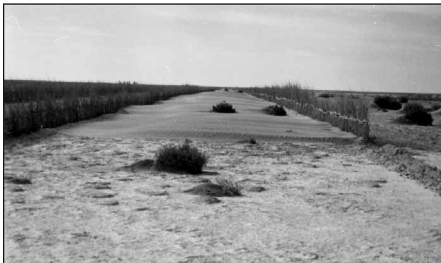
تصویر ۶- احداث بادشکن مرده (تله های رسوبگیر)
