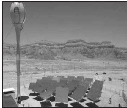
عکس ۱، احداث نیروگاه خورشیدی در صحرای آفریقا
